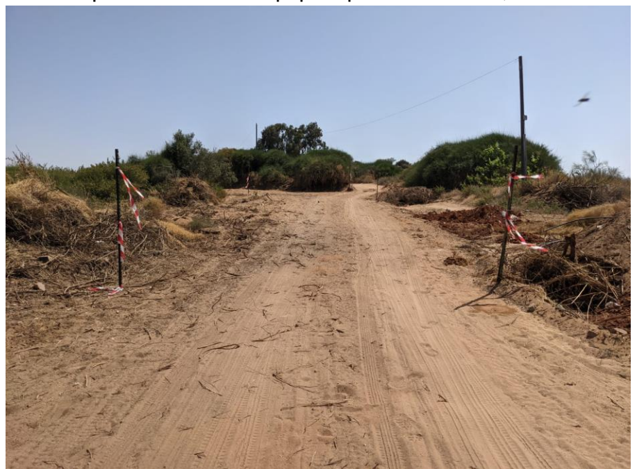
בתמונה למטה, ברזלי זווית שנתקעו בקרקע כהכנה לגדר על דרך הכניסה הצפונית מזרחית
