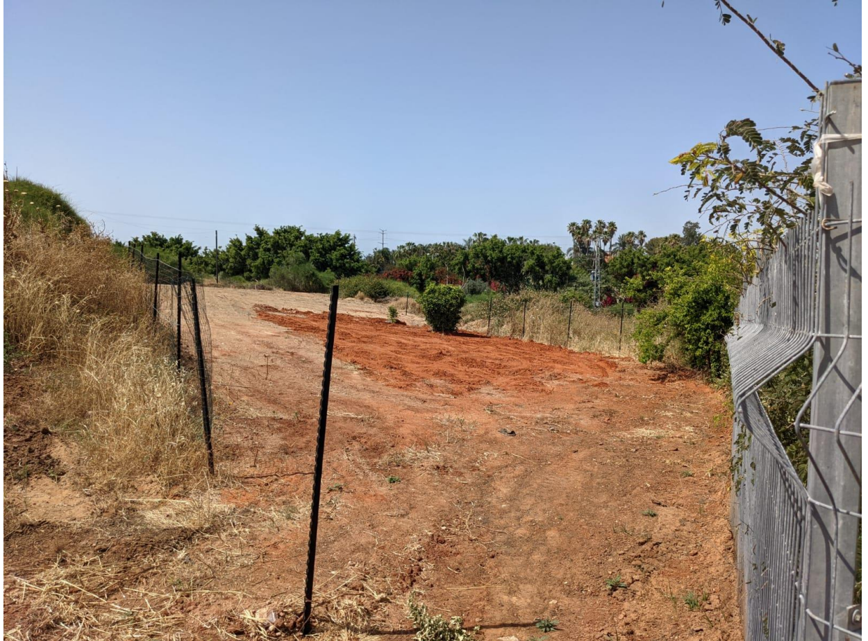
בתמונה למטה, ברזלי זווית שנתקעו בקרקע כהכנה לגדר על דרך הכניסה הצפונית מזרחית
